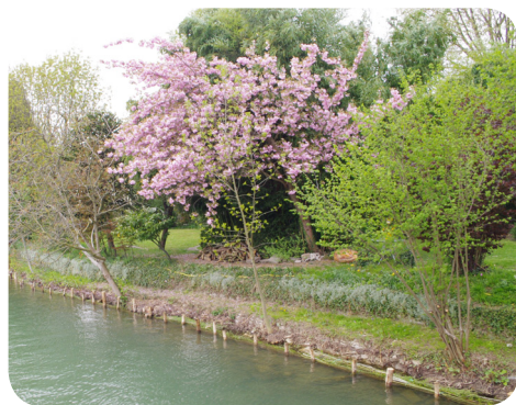
Les berges côté Marne après travaux
